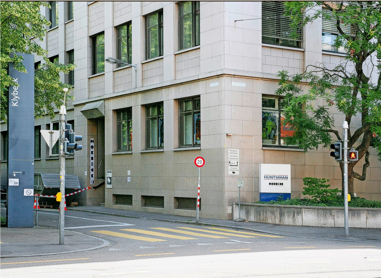
Der erste Stock in der Zwischennutzung Horbeck ist zurzeit wegen Asbest im Liegestaub geschlossen. Foto: Nicole Pont
