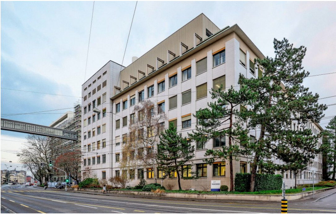
Im ersten Stock des «Horbeck» wurde nach der Sanierung Asbest nachgewiesen. Bild: Kenneth Nars
