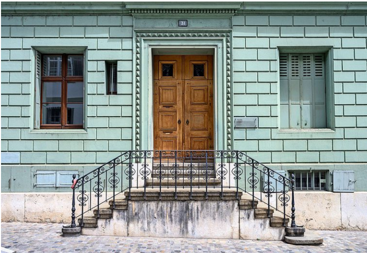
Diese Tür darf durch eine Kopie ersetzt werden. Foto: Dominik Plüss
