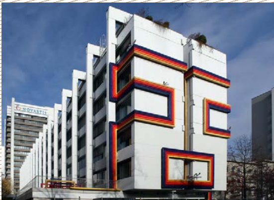
Kerim Seiler hat dem Campusgebäude, das heute auch die konzernneigene Kinderkrippe aufnimmt, ein neues Gesicht gegeben.
