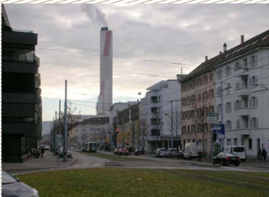
Mit dem Wegzeichen (1979–1981) hat Hannes Vogel den Kamin des Fernheiz-Kraftwerks zu einem ambivalenten Orientierungspunkt gemacht. Von wo geht unsere Stadtwanderung und wohin?
